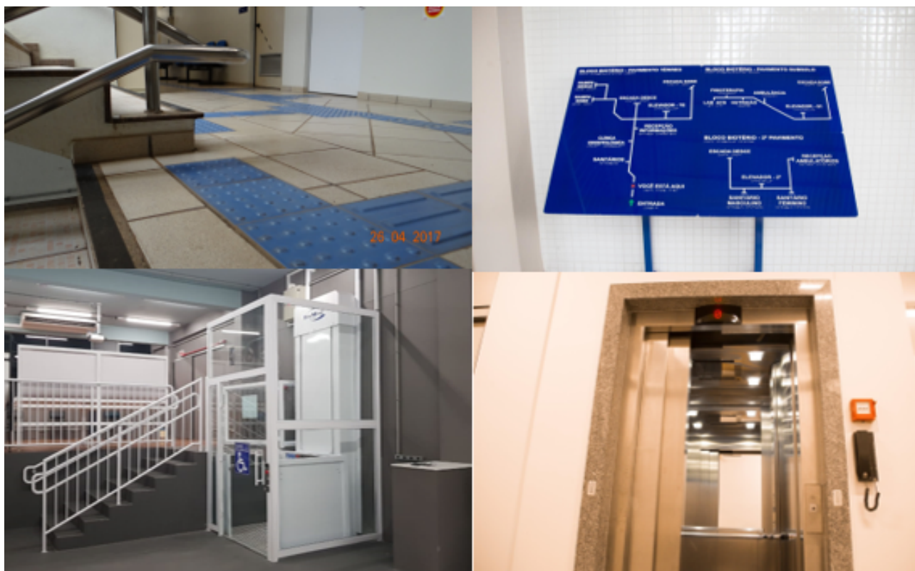
Figura 35 - Piso tátil, mapa tátil, plataforma elevatória e elevador, exemplos de acessibilidade arquitetônica distribuída pelo campus
