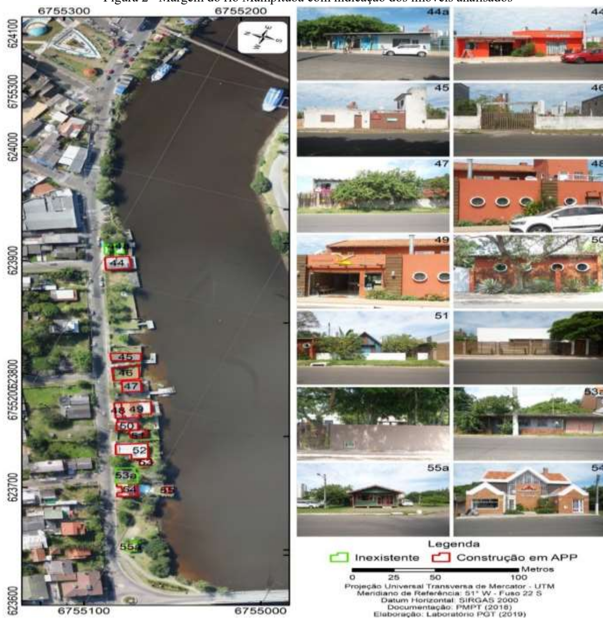
Figura 2 –Margem do rio Mampituba com indicação dos imóveis analisados
