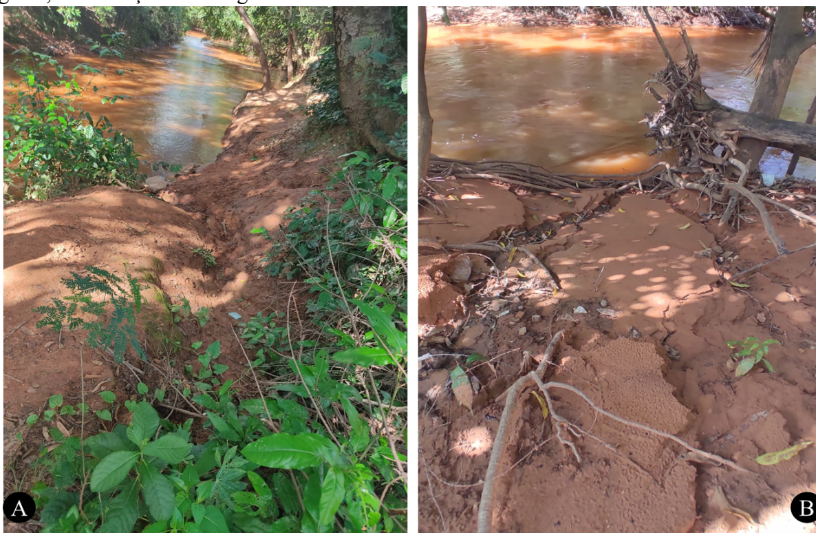
Figura 2 A e B – Ocorrência de processo erosivo e desagregação do solo às margens do Rio Gurguéia, São Gonçalo do Gurguéia – Piauí.
