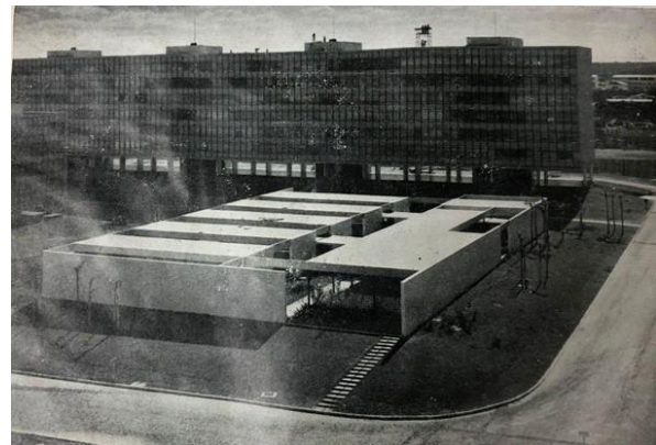
Figura 1 – Vista superior da Escola-Classe 114 Sul. Fonte: Revista Módulo .
