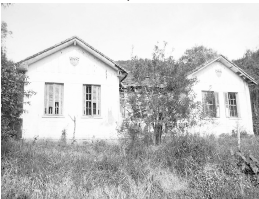
Figura 07 - Arqueologia industrial: Pousada de trabalhadores ferroviários em Rio Uruguai, Piratuba
