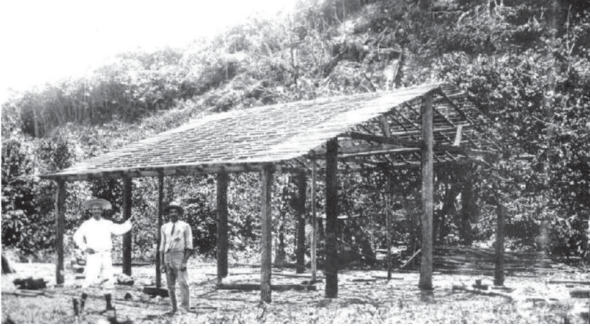
Figura 04. Uma casa de Boiçucanga, São Sebastião, passo a passo, em 1923. Nesta etapa vemos as colunas e a estrutura do telhado.
