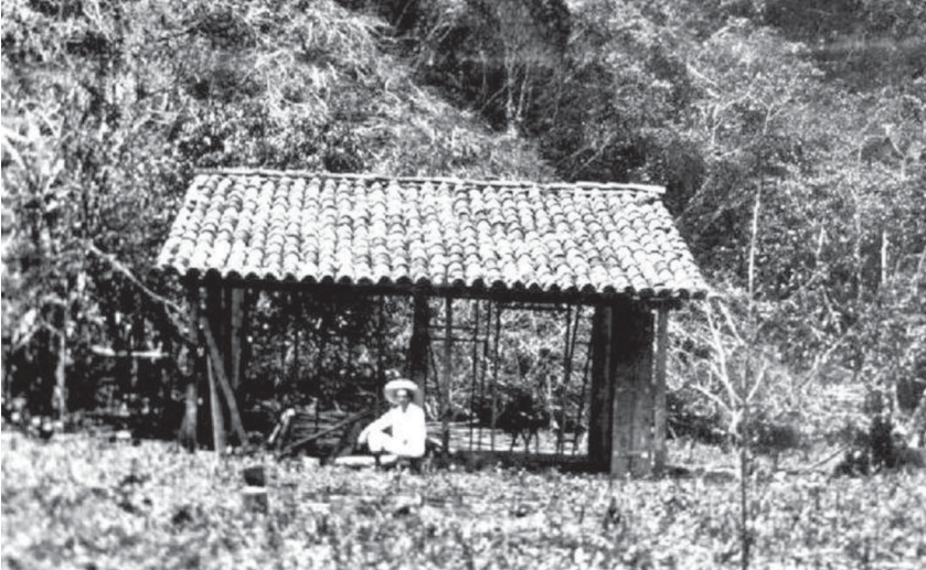
Figura 05. Já com a cobertura, em telhas cerâmicas.
