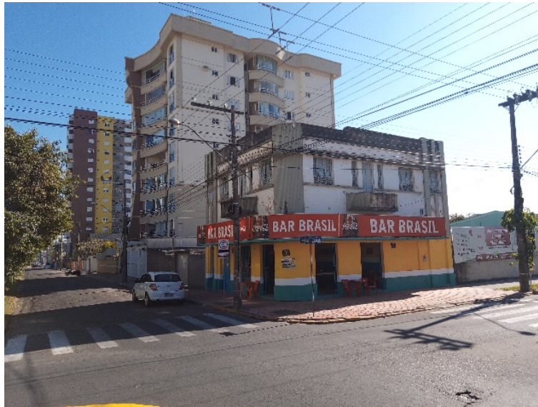
Figura 13 - Prédio na Av. 15 de Novembro [Bar Brasil].
