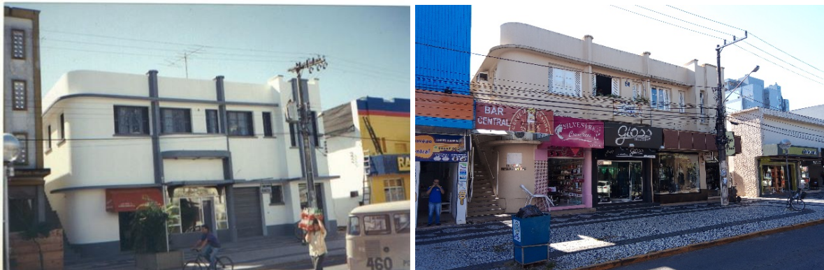
Figura 14 - Prédio nº 191, localizado no Calçadão da Av. Getúlio Vargas (na imagem da esquerda o prédio na década de 1990 e na da direita o prédio em 2015). Percebe-se o grande número de placas de publicidade que encobrem e descaracterizam o prédio.
