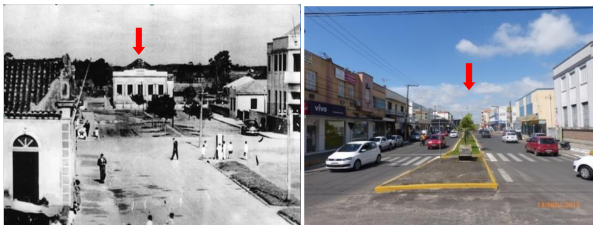
Figura 9 - Imagem da esquerda mostrando a localização da casa do Coronel João Fernandes, onde hoje (imagem da direita) passa a Av. 7 de Setembro.
