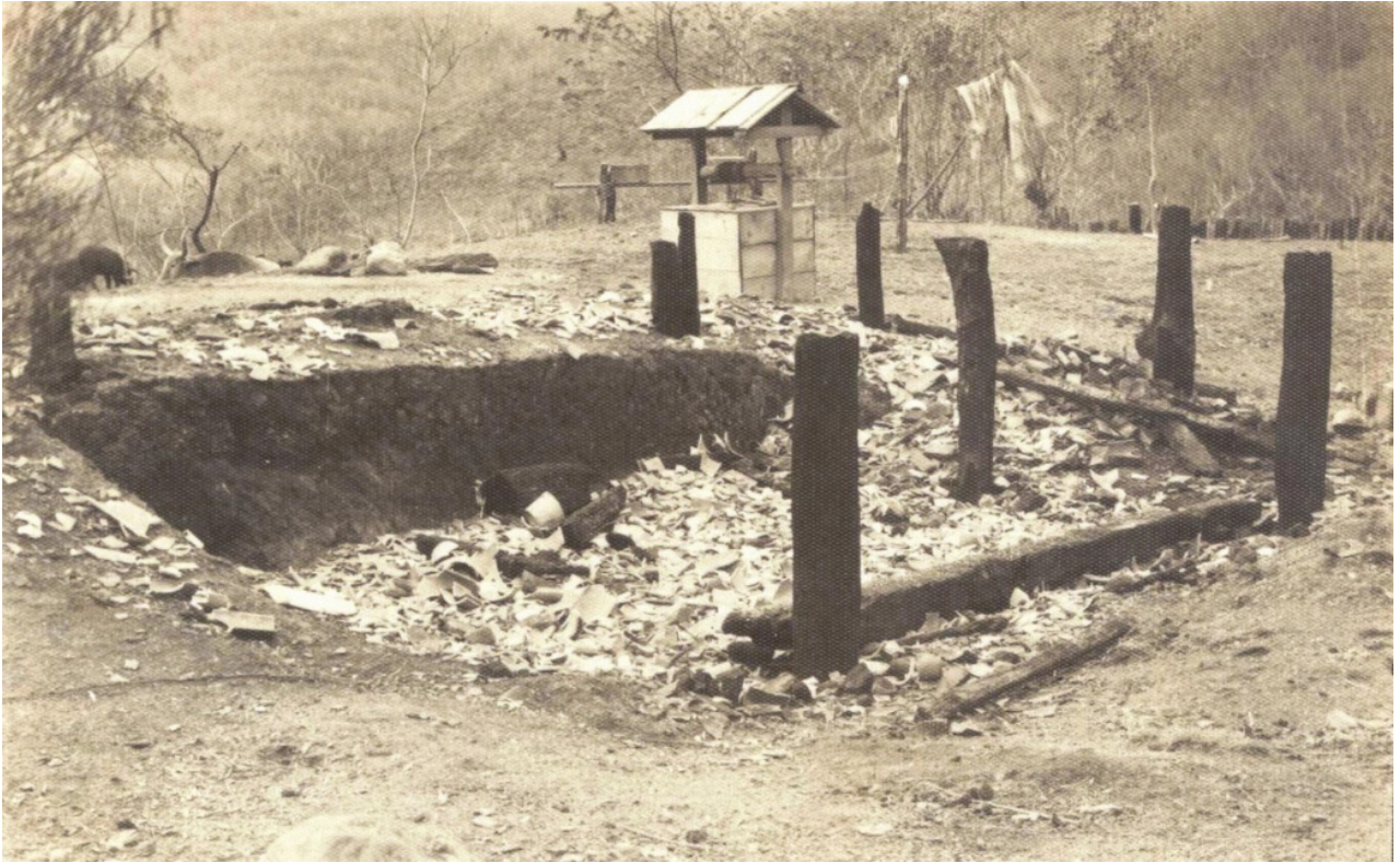
Figura 4 – Residência destruída pela ação do fogo no município de Orleans. Fonte: CEDOHI, autor desconhecido.
