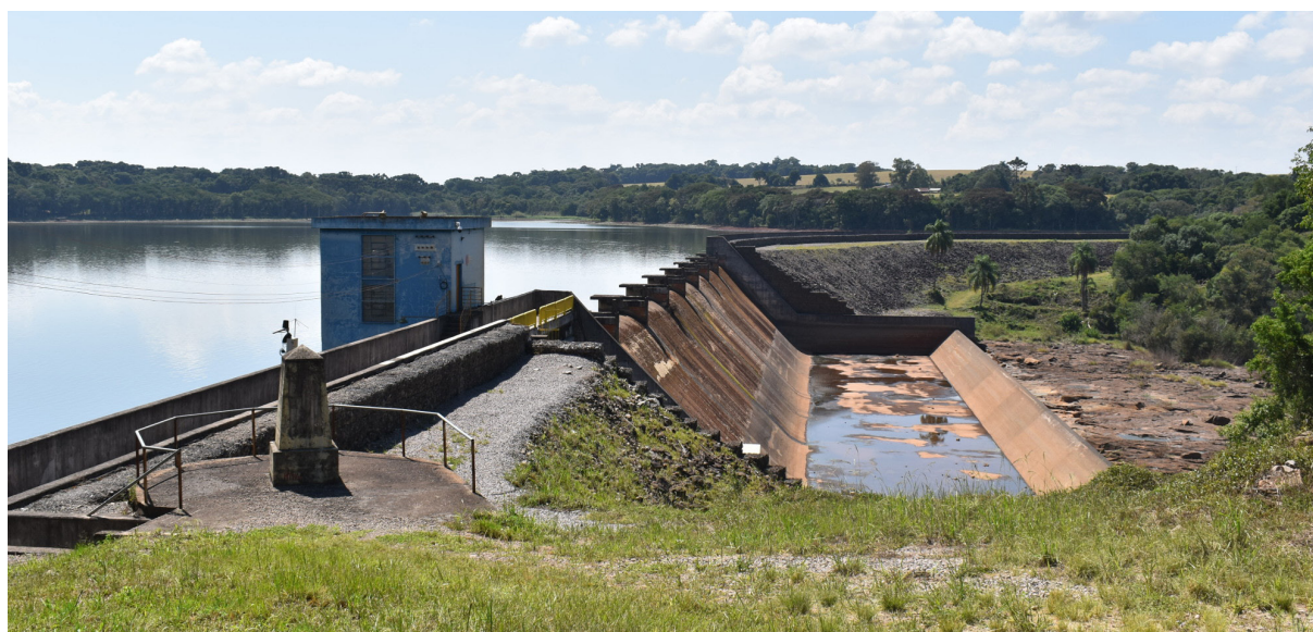
Figura 11 – A barragem da Usina Hidrelétrica de Ernestina
