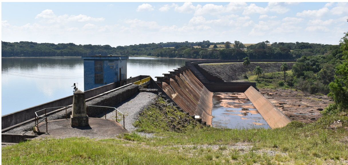
Figura 11 – A barragem da Usina Hidrelétrica de Ernestina
