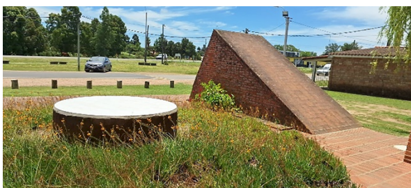
Figura 7 - Acesso externo e sistema de iluminação natural do batistério
