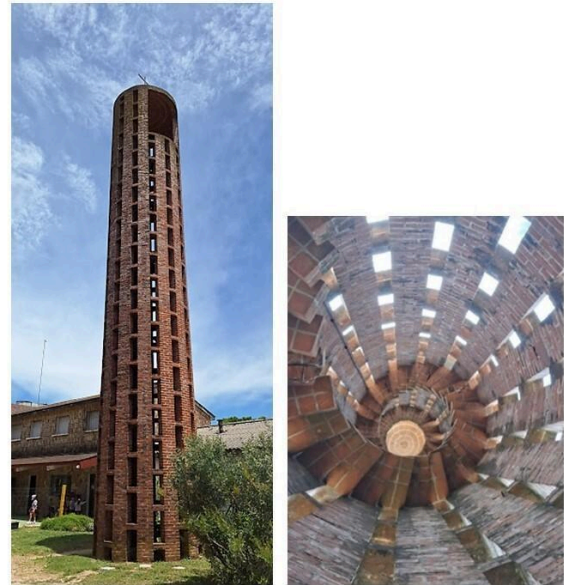
Figura 5 - À esquerda, vista externa da torre; à direita, vista interna da torre
