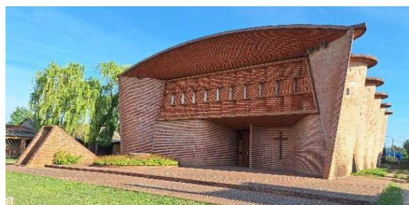
Figura 2 - Fachada da Igreja de Atlântica
