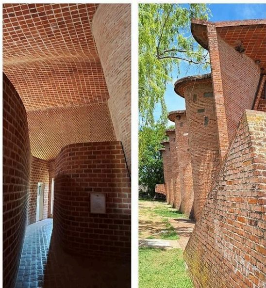
Figura 4 - À esquerda, paredes internas e teto; à direita, parede externa
