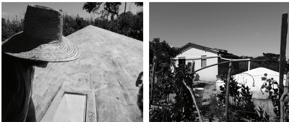
Figura 3 – Cisternas de placas.
